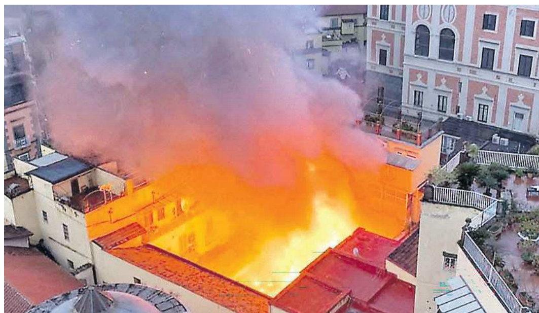
L'incendio che il 17 febbraio ha distrutto lo storico teatro Sannazaro nel cuore di Chiaia
